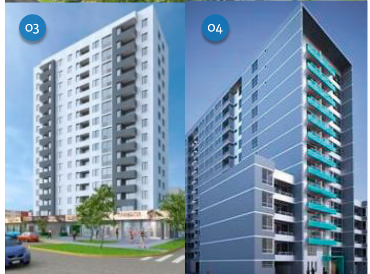
1. Edificio QUINTA DE EL PARQUE · RVC 2. Edificio AIRES NUEVOS · MAESTRA 3. Edificio ALTO CARRASCAL · NIZA 4. Edificio SIXTINA · PERSEVERANCIA RADAL
